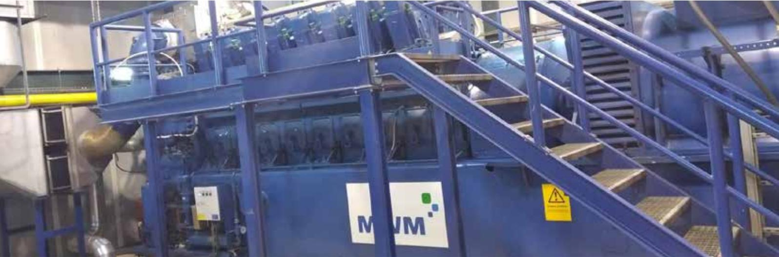
MWM TCG 2032 B 4,5-MW-Gasmotor | BHKW in einem Werk für das Färben und die Endbearbeitung von Textilien | Portugal
